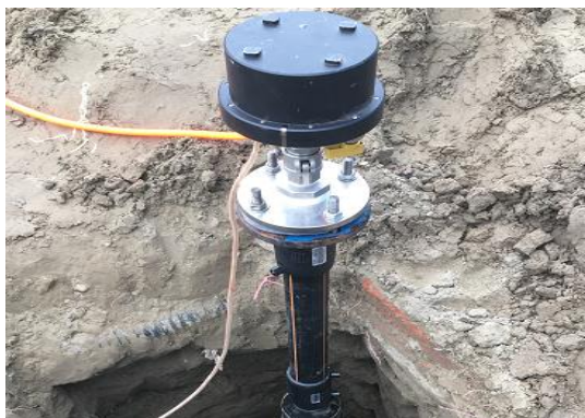
图 2-3 法兰盘连接
