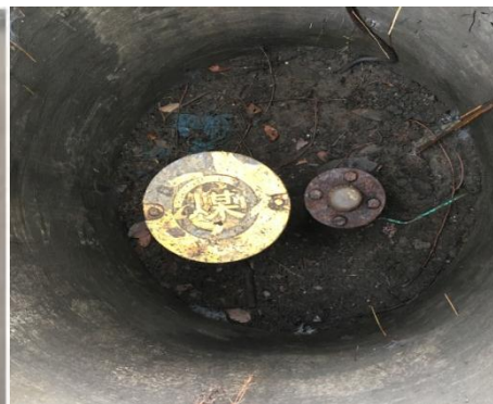
图 2-8PE 球阀法兰放散口
