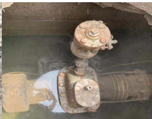
图 2-4 法兰盘连接
